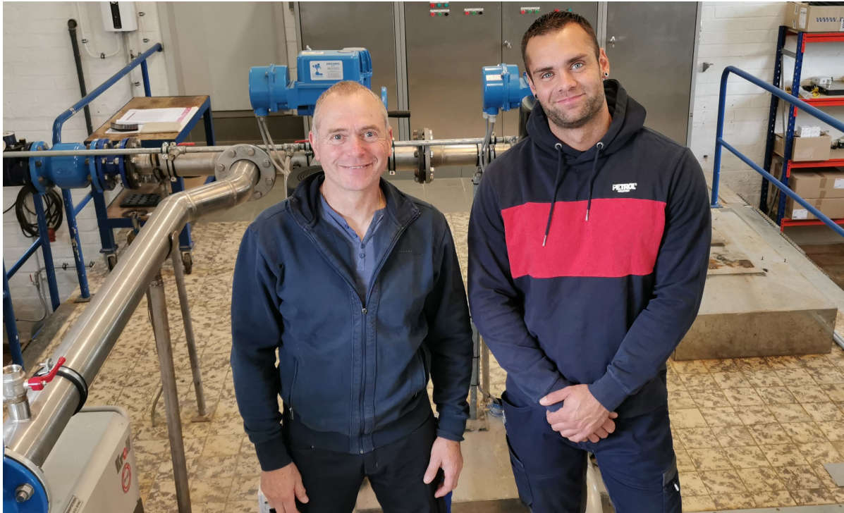
Der ehemalige Wassermeister Patrick Herzet (links) und sein Nachfolger Patrick Kaiser in der Pumpstation Roter Pfuhl
