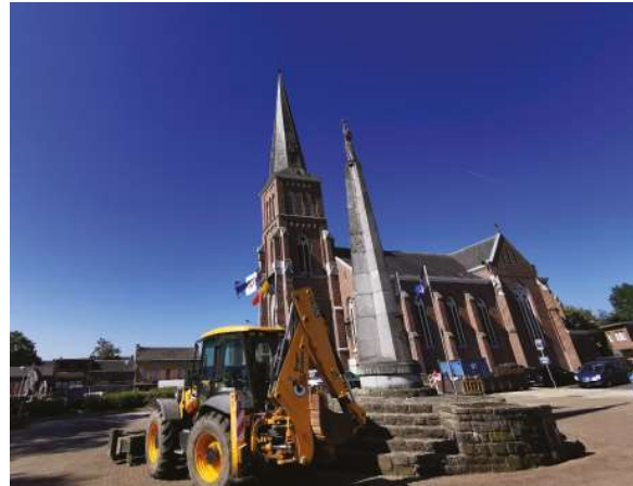
Die Bauarbeiten starteten am 8. Juni.
